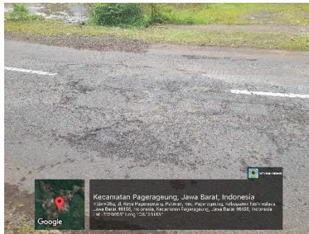
Kerusakan Permukaan Jalan Eksisting
