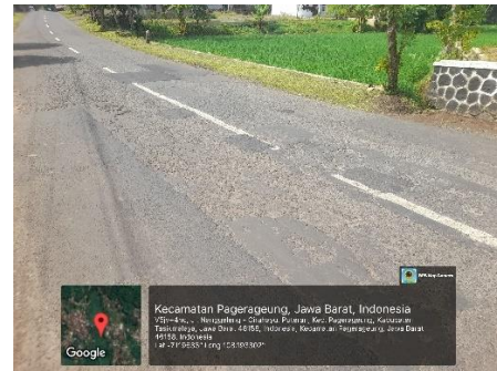
Kerusakan Permukaan Jalan Eksisting
