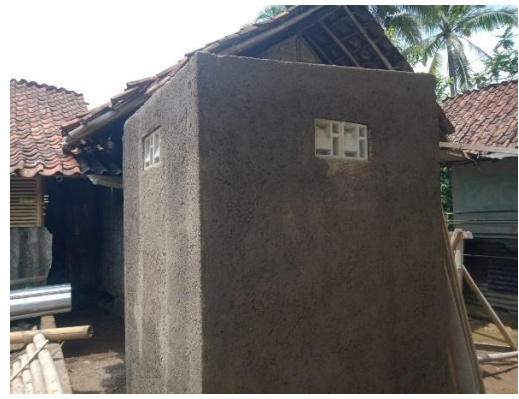
Gambar 8 Pembangunan Jamban Sehat
