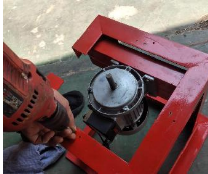
Gambar 5.15 Pemasangan Motor Penggerak
