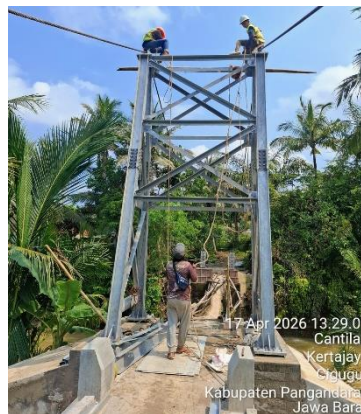
Gambar 5. 1 Pekerjaan Struktur Atas
