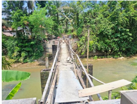
Gambar 5. 4 Eksisting Jembatan Ciharuman
