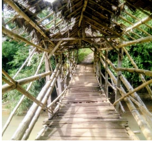
Gambar 5. 6 Eksisting Jembatan Ciharuman saat air sungai tinggi
