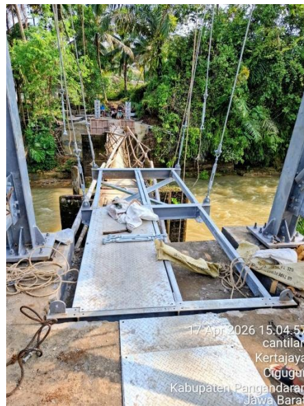
Gambar 5. 1 Proyek Jembatan Gantung
