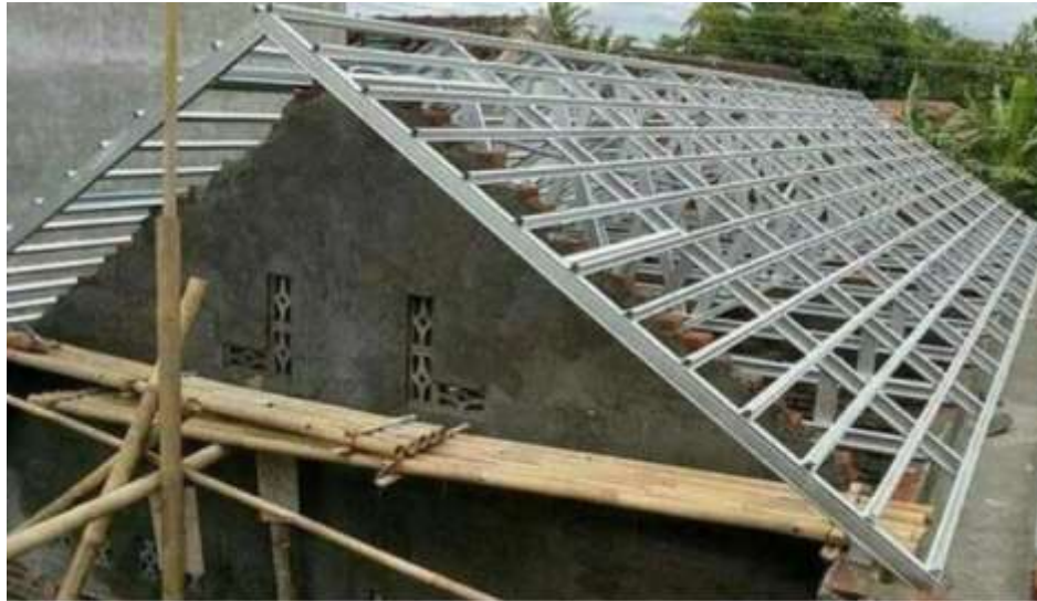
Gambar 3.1 Rangka Atap Baja Ringan (Sumber : kawat bersinar5)
