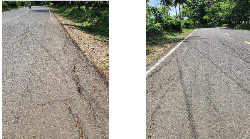
Gambar 4.1 Kondisi eksisting Sumber: Dokumentasi Pribadi
