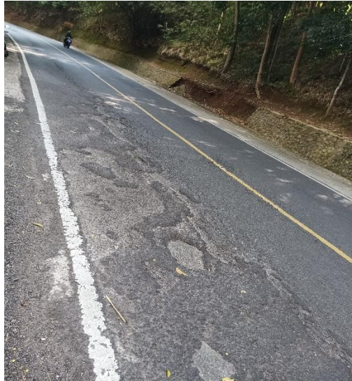
Gambar. Cacat Permukaan ( Disintegration )
