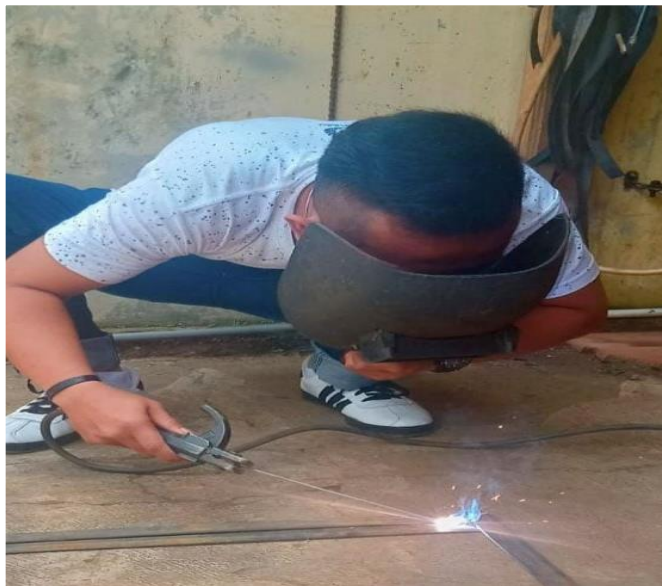
Gambar Pengelasan Plat
