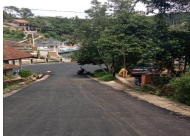
Gambar 4.23 Kondisi Jalan Situ Wangi
