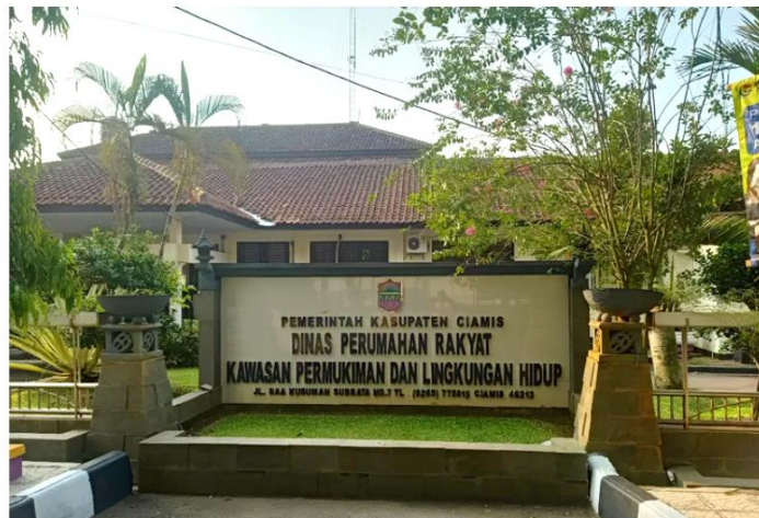
Kantor DPRKPLH Kabupaten Ciamis, tampak depan /Kayan Manggala/
