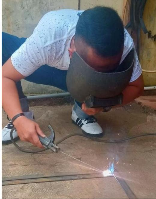
**Gambar 4.11** Pengelasan Rangka
