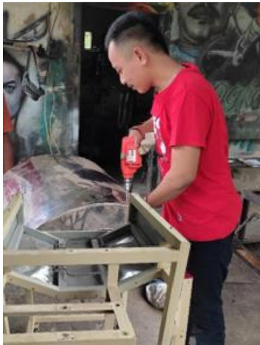
**Gambar 4.13** Proses Pengeboran rangka
