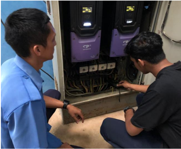
Pengecekan Inverver Didampingi Pembimbing Lapangan
