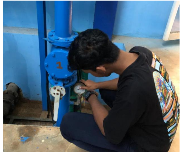
Pengecekan Tekanan Pompa Pada Manometer
