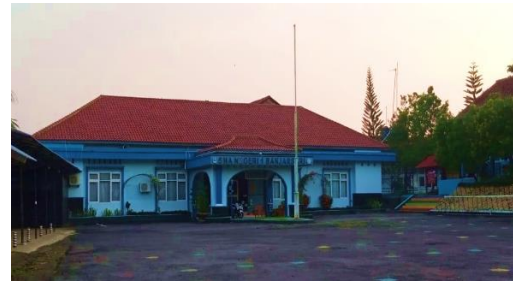
Bangunan Sekolah SMA Negeri 1 Banjarsari
