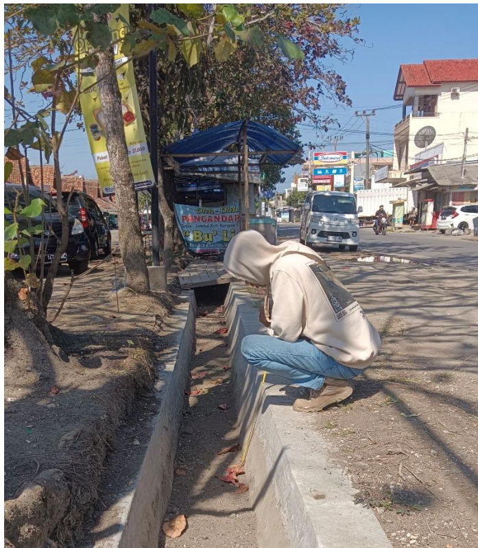
Gambar Pengukuran Dimensi Saluran Drainase
