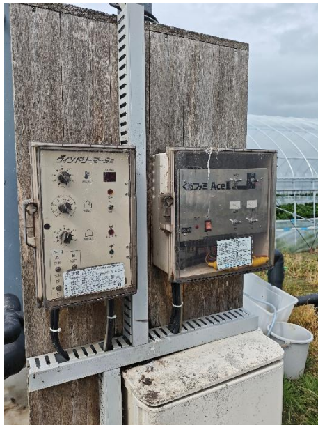
Kontak kontrol suhu otomatis
